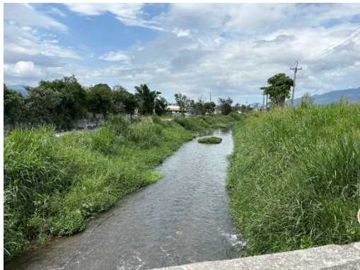
工區範圍河道 (向下游拍攝)
