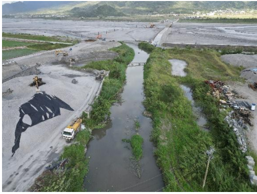
工區範圍河道 (向下游拍攝)
