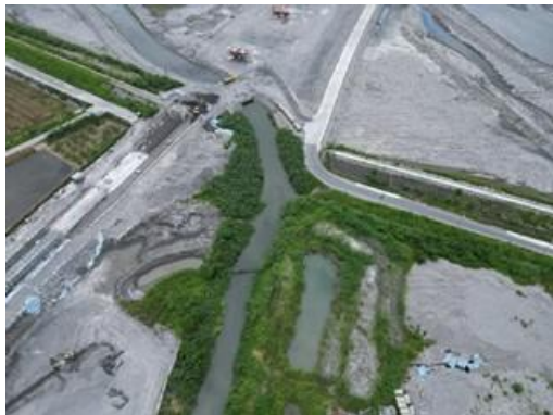
工區範圍河道(向下游空拍)
