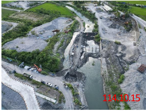
工區範圍河道(向上游空拍)
