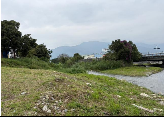
施工便道預定地
