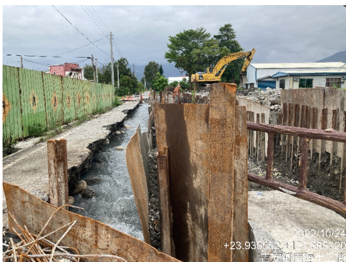
下游工區導排水措施(111/10/24)
