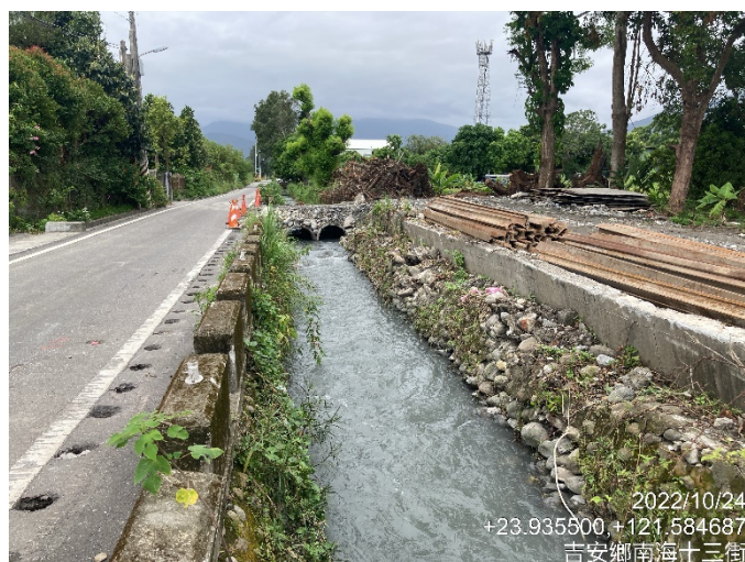
施工便道涵管(111/10/24)
