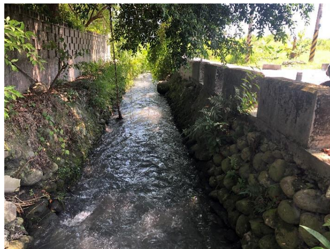
整體環境樣貌，兩側漿砌護岸
