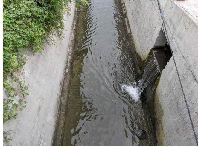
水圳為水泥封底，無底質覆蓋(110/11/11)
