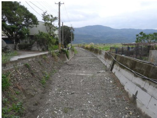
工區範圍河道 (向下游拍攝)
