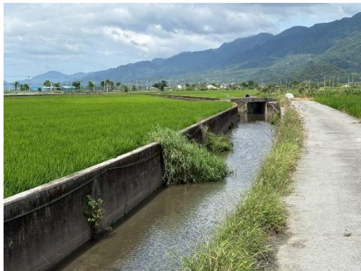
工區範圍河道 (向下游拍攝)
