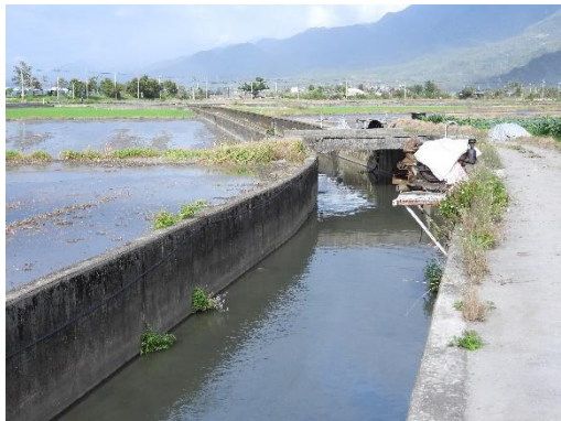
工區範圍河道 (向下游拍攝)
