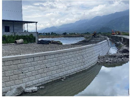
新設之造型護岸
