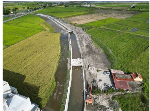
工區整體空拍
