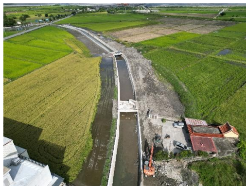
工區整體空拍
