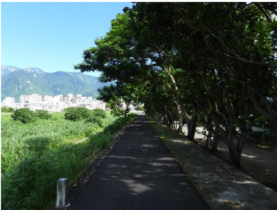
堤頂自行車道現況
