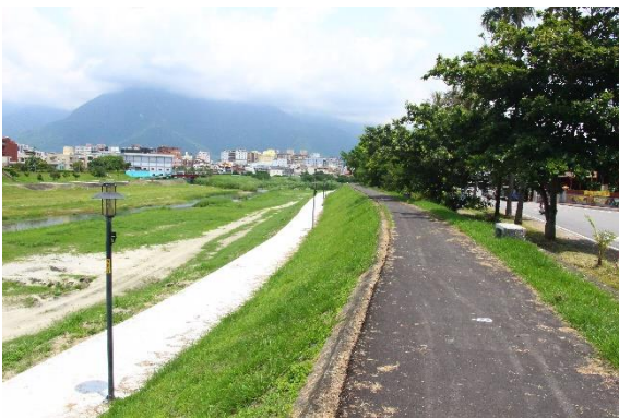
堤頂自行車道現況
