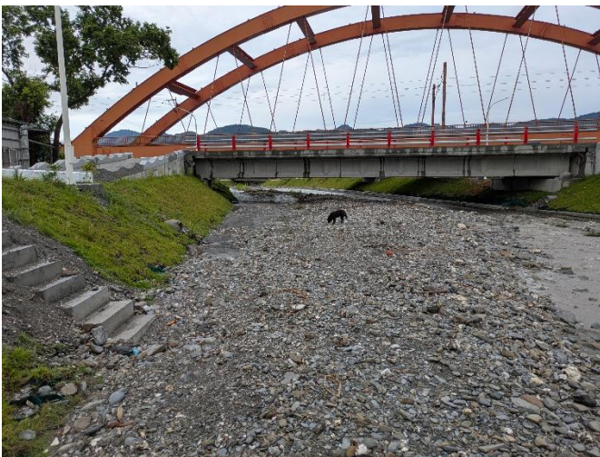
上游與工區交界處(紅框為工程範圍)(7 月)
