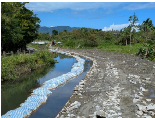
A 區工程現況
