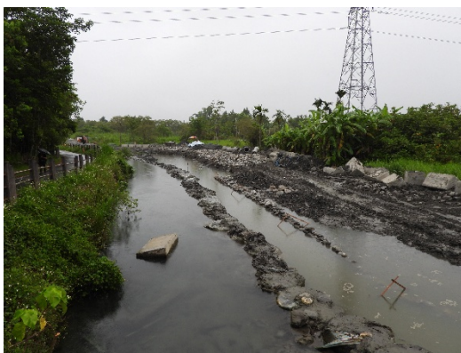
A 區環境現況
