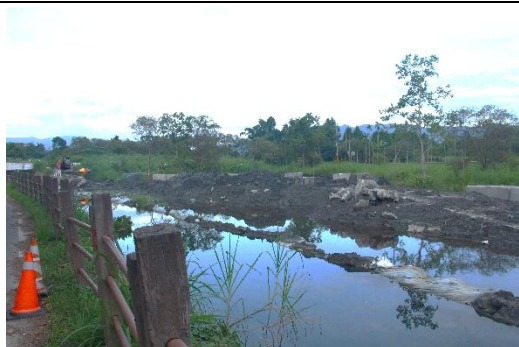
A 區工程現況
