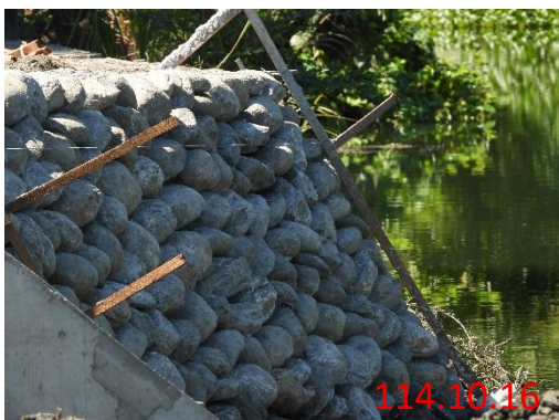
落實漿砌石護岸不勾縫原則
