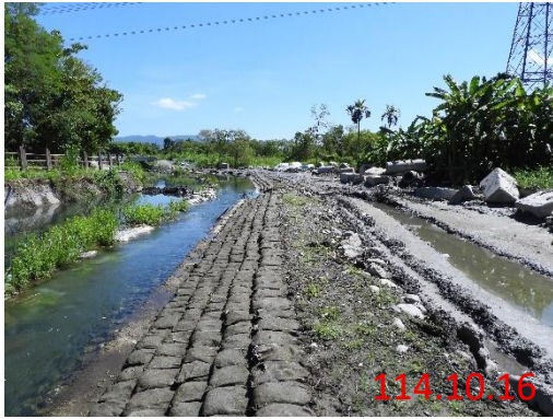
A 區右岸護岸主結構目前已完成
