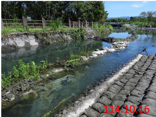
A 區左岸護岸正以土包袋圍水
