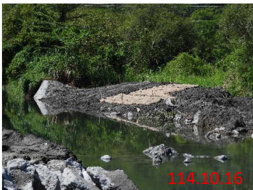
上游左岸緩坡化狀態
