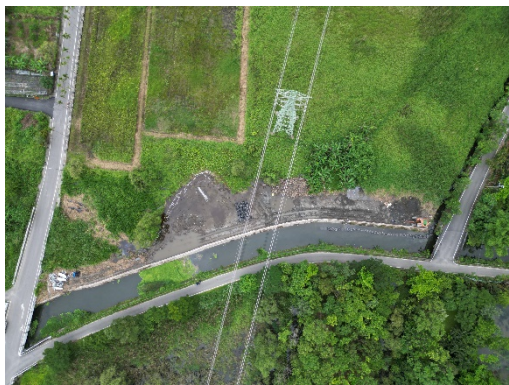
A 區環境現況
