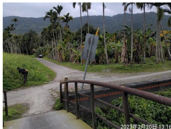
下游滯洪池南側與光復溪堤後坡(112/02/20)
