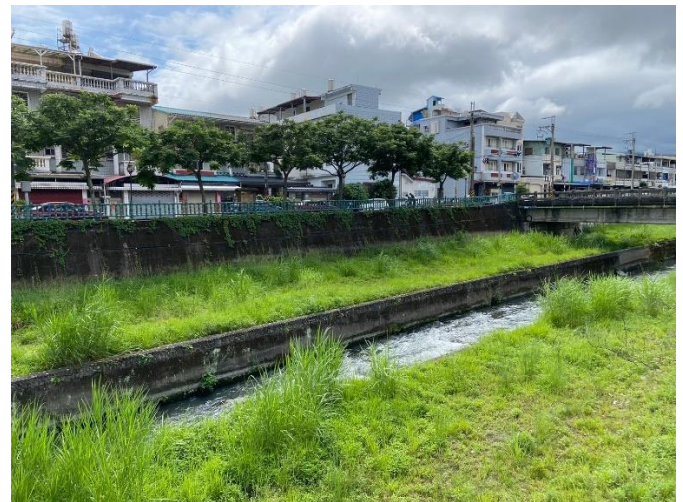
濱水護岸現況(112/05/17)
