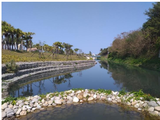
吉安工區河道現況 (112/03/08)
