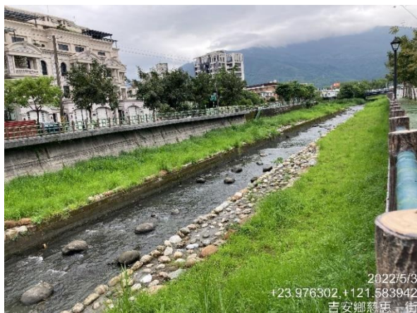
吉安溪中游段慈惠一街設置塊石形成瀨區 (111/05/03)
