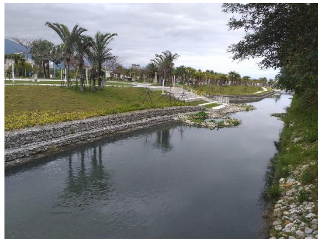
吉安工區河道現況(112/03/08)
