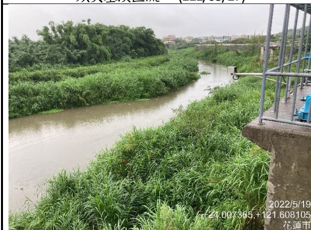
新生橋下游國強抽水站往下游拍攝 (111/05/19)
