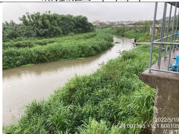
新生橋下游國強抽水站往下游拍攝 (111/05/19)
