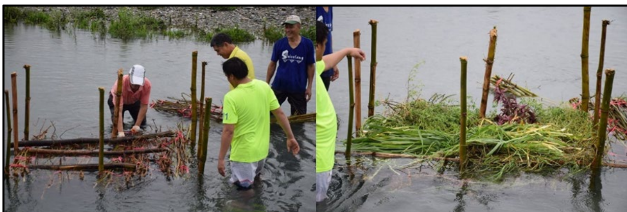
圖 2-5 竹圈以十字法層層相疊並放入水草固定
