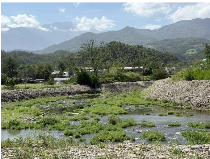
前次現勘狀況(114/04/14)
