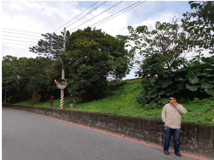
圖二、2020 年 2 月明禮抽水站堤後坡尚未大規模動工，保全對象皆存在。
