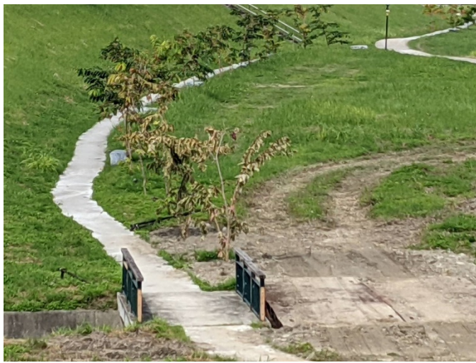
明里堤防新植喬木現況-疑似現工程誤傷 (110/11/17)
