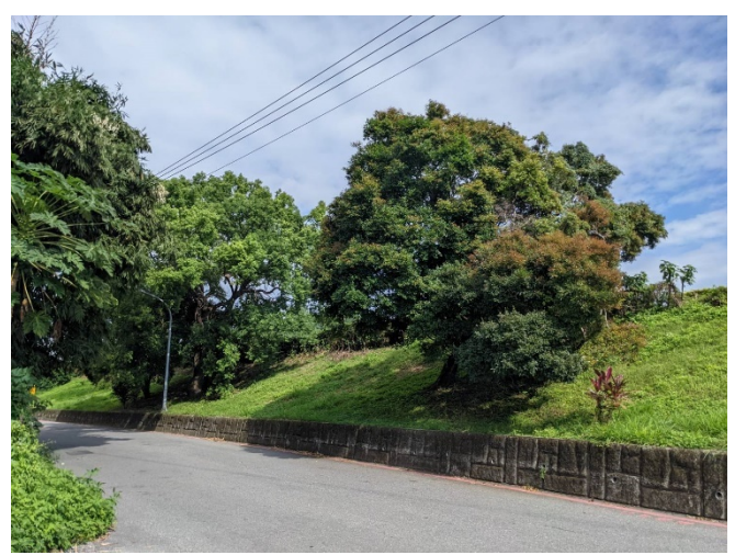
明里堤防堤後坡保全對象狀況良好 (110/11/17)
