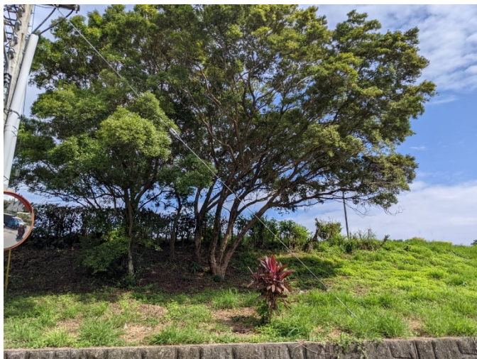
明里堤防堤後坡保全對象狀況良好 (110/11/17)
