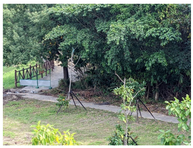
明里堤防新植喬木有枯萎現象 (110/11/17)
