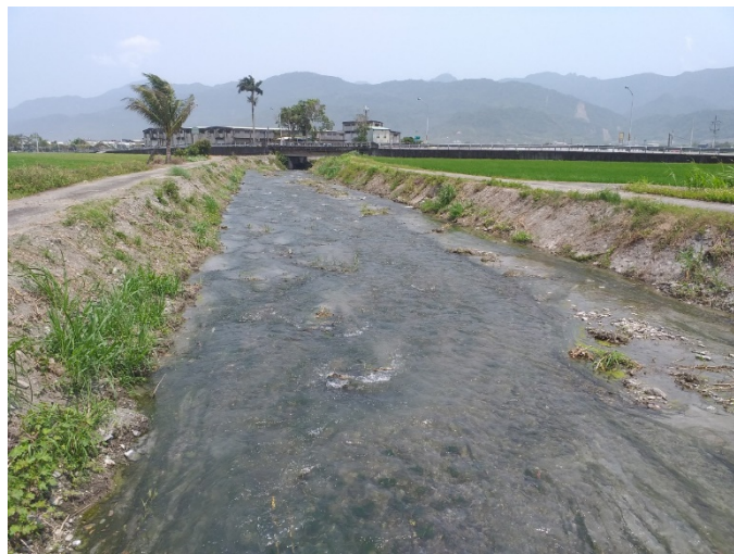
三期治理工程區段客城鐵路橋往下游拍攝 (112/07/06)
