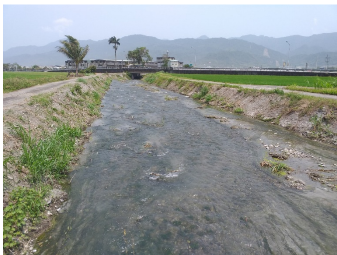
三期治理工程區段客城鐵路橋往下游拍攝 (112/04/18)
